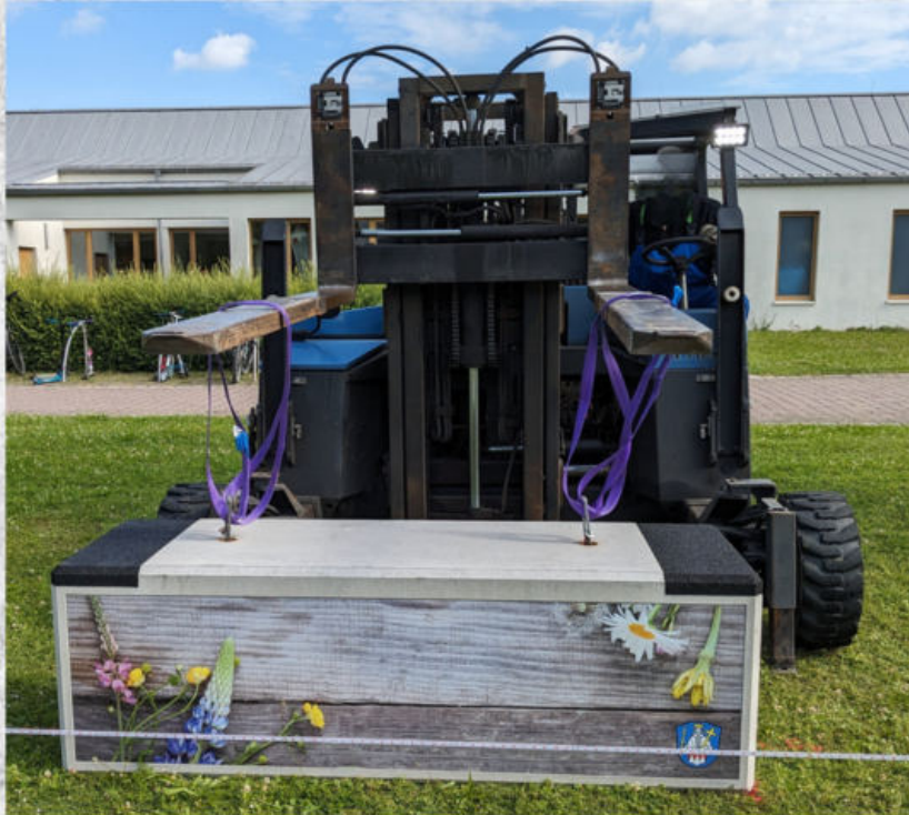
Einbau der Abhebeschlaufen und Rundschlingen (lila) zum Positionieren der Blöcke
