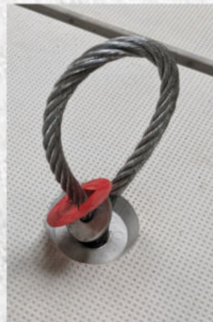
Abhebeschlaufen komplett eindrehen
