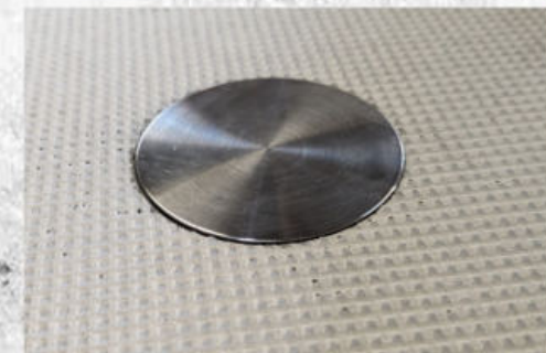
Edelstahl-Verschluss-Deckel für Ankerhülsen - mit Schraubensicherung komplett eindrehen (falls Wasser in der Hülse dies entfernen)
